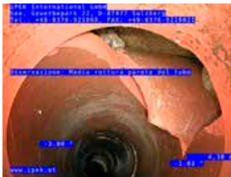
Ispezione stato di manutenzione reti fognare
