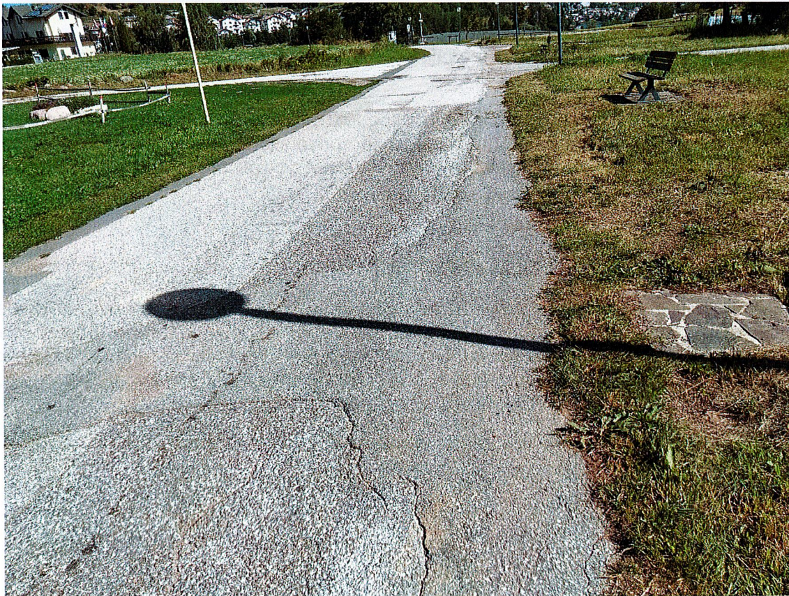
Foto 2: intervento lungo via del Cadrobol
