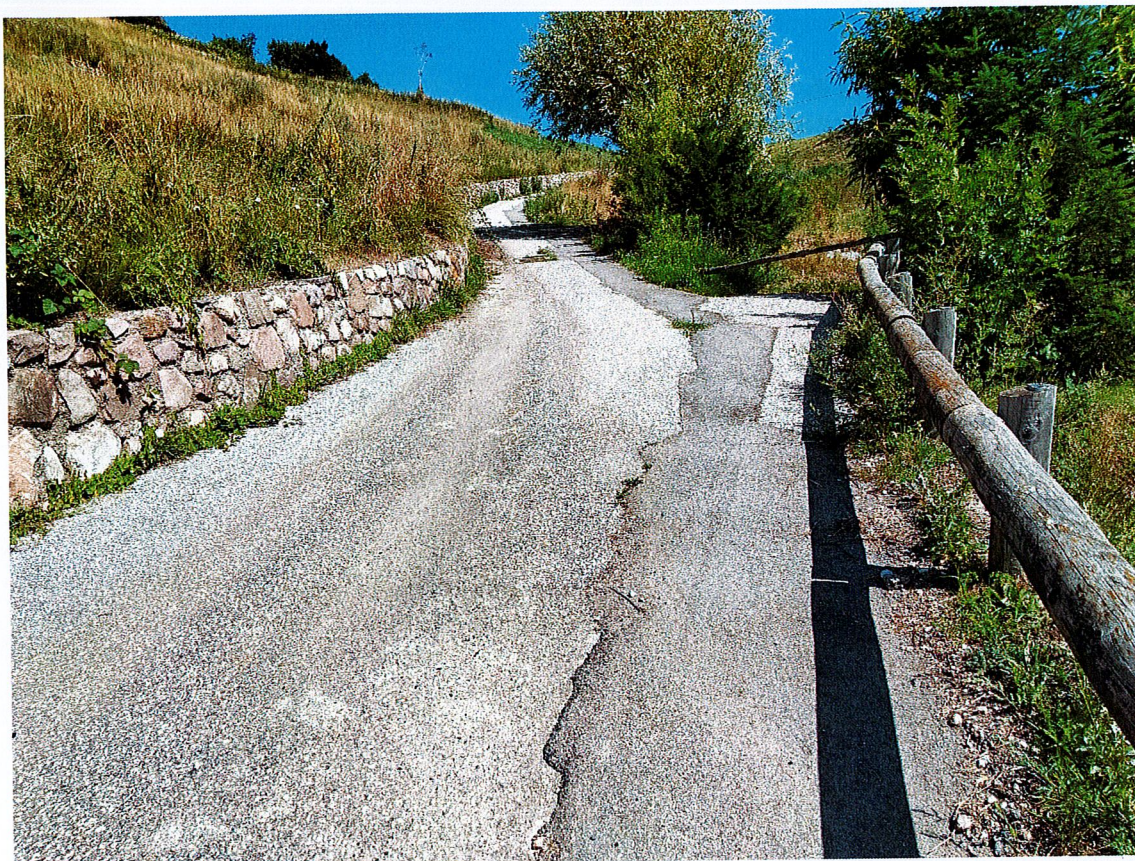
Foto 3: intervento lungo via dei Solari
