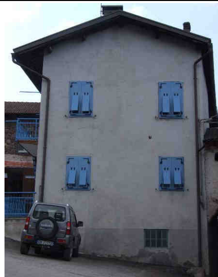
Scuri a due ante di colore azzurro, con riquadratura nella parte superiore e in quella inferiore.
