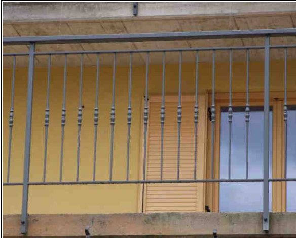
Poggiolo in cemento con parapetto in ferro a disegno semplice.
