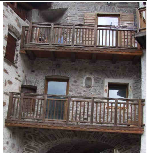
Poggiolo in legno con parapetto pure in legno del tipo “alla trentina”. Colore naturale.
