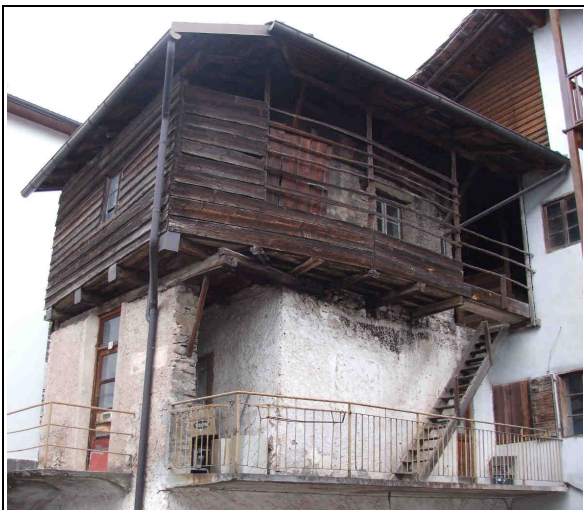
Poggiolo in legno con parapetto pure in legno, ad assicelle orizzontali utilizzate, nel passato, per l'essicazione dei prodotti agricoli.
