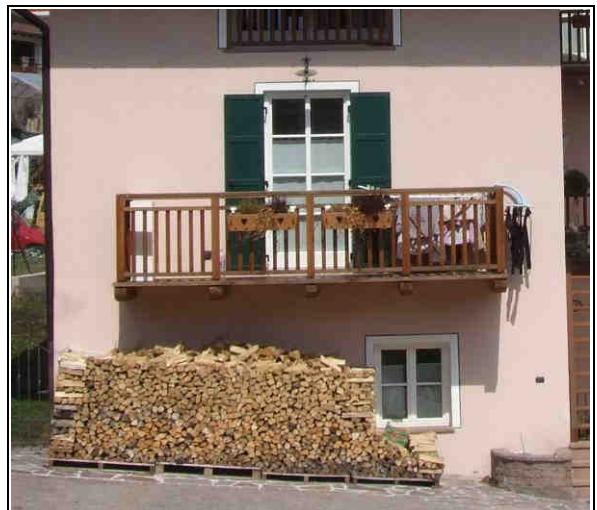
Poggiolo in legno con parapetto pure in legno, del tipo “alla trentina”. Colore naturale.
