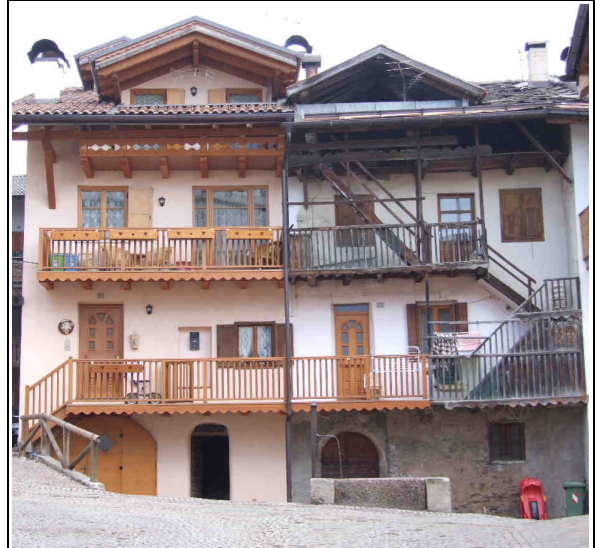
Parapetti in legno alla “trentina”. Color legno naturale. Mantovane sagomate ad arco. Parapetto al piano sottotetto variamente sagomato.
