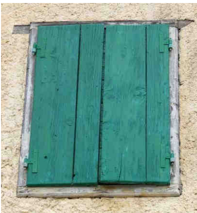
Scuri a due ante color verde, con assi longitudinali nella faccia esterna. Cornice della finestra anch'essa in legno.
