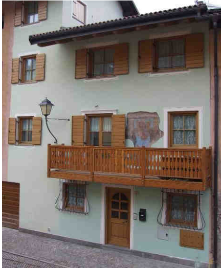
Parapetto in legno con assi verticali riccamente sagomate. Colore naturale.
